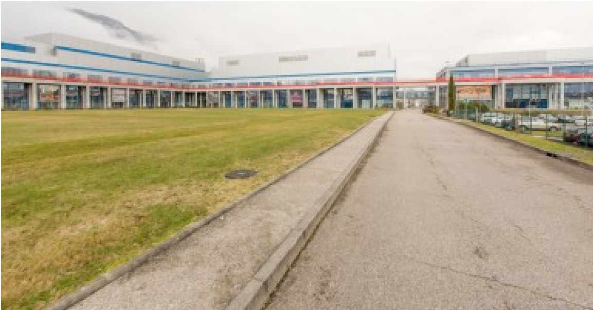
Le site de production STMicroelectronics de Crolles avec la Fab300 fabricant des wafers de 300 mm en technologie 28 nm.
