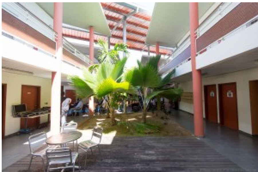
Le bâtiment de Guyane Développement Innovation abrite une dizaine de startups et TPE innovantes ainsi que le Numlab, mélange de fablab et d'atelier de développement logiciel.
