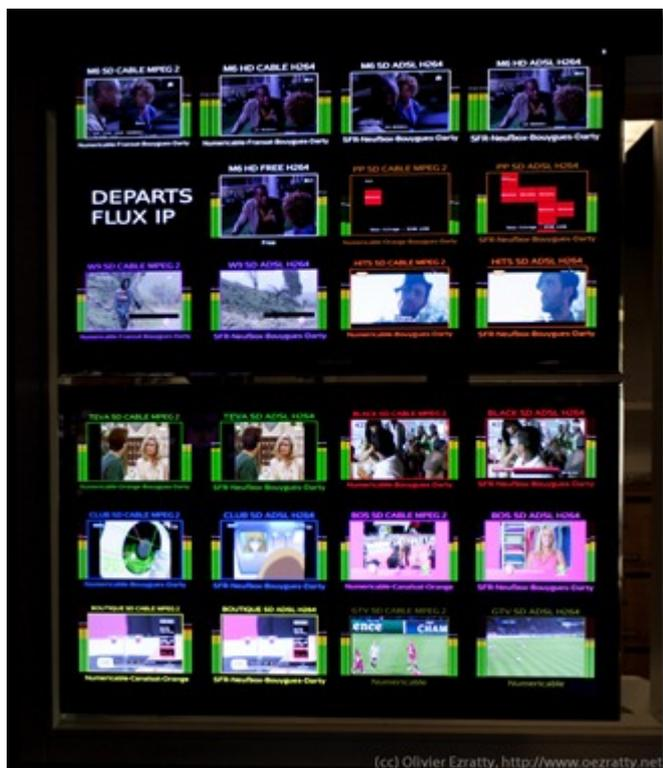
Le monitoring des retours des FAI est réalisé avec le logiciel de **Volicon** lié à une batterie de set-top-box de chaque FAI. Celui-ci vérifie pour chaque set-top-box et de manière cyclique toutes les chaînes du groupe et pendant dix secondes par chaîne.
