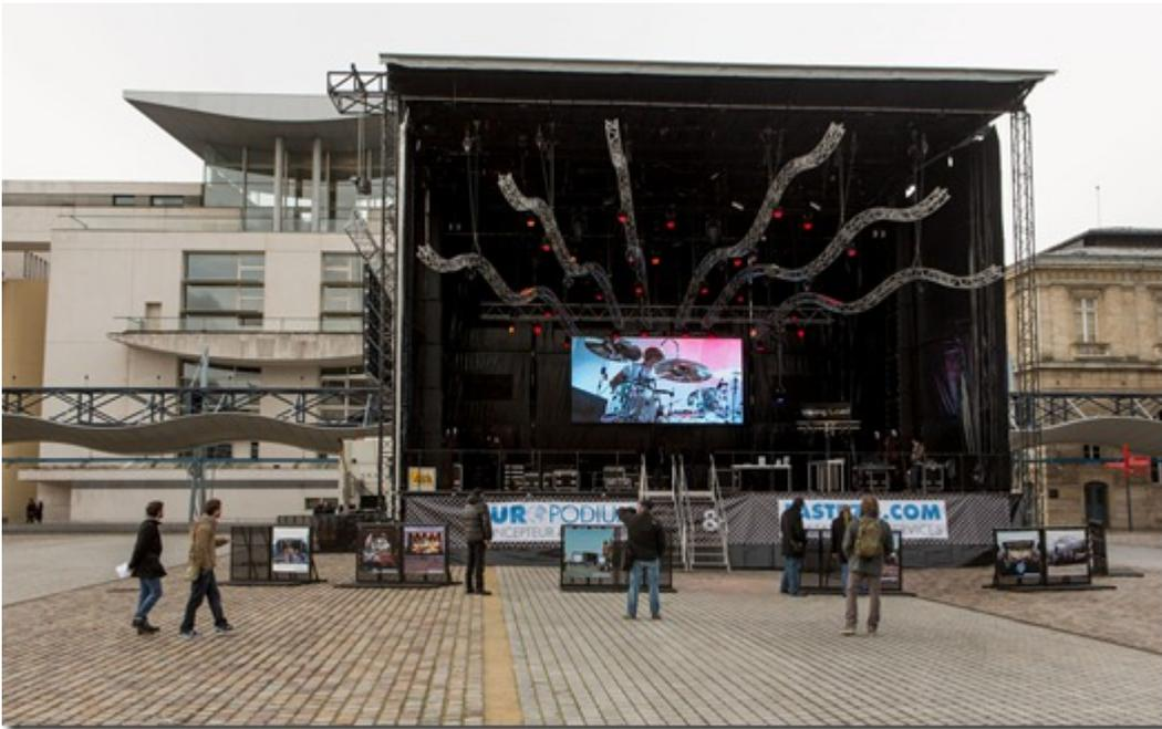
Elle semble tenir tout entière dans un 32 tonnes, dont la remorque était placée sous la scène et lui servait de support central. Un système de levage de part et d'autre de la scène permet d'en monter le toit et de soulever le tout avec deux gros vérins hydrauliques.
